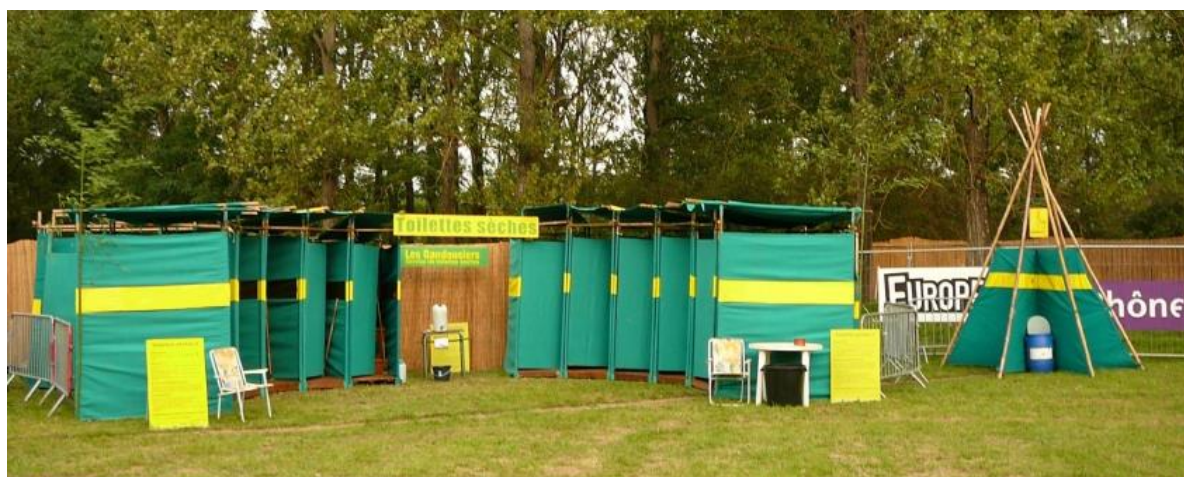
Figure 14: Cabines TLB et urinoirs en tissu, démontables. Photographie : Les Gandousiers
